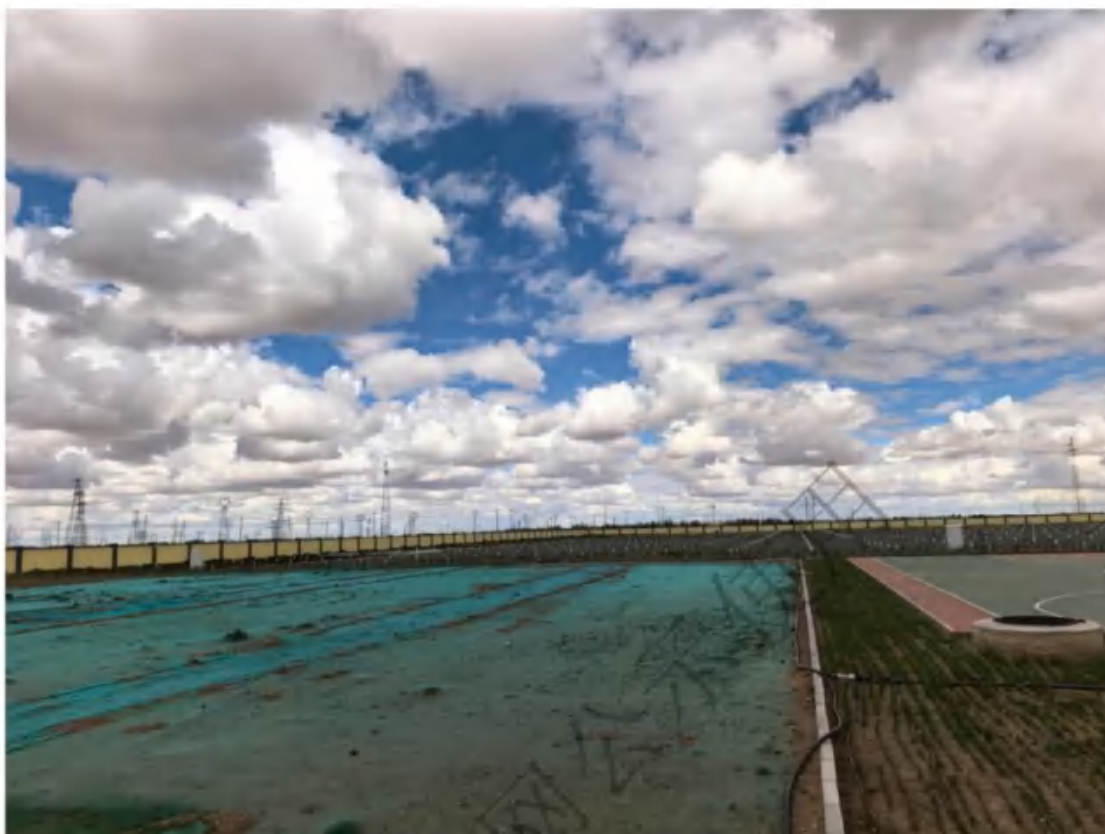
中心场区裸露空地密目网苫盖
