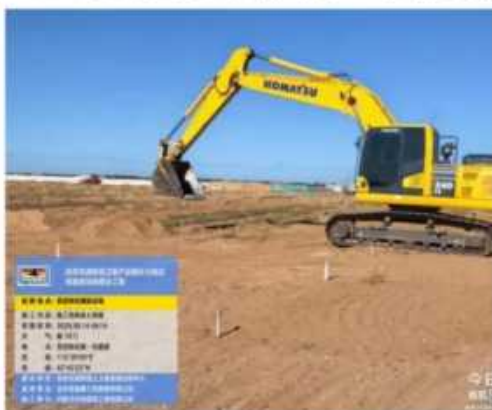
中心场区表土剥离
