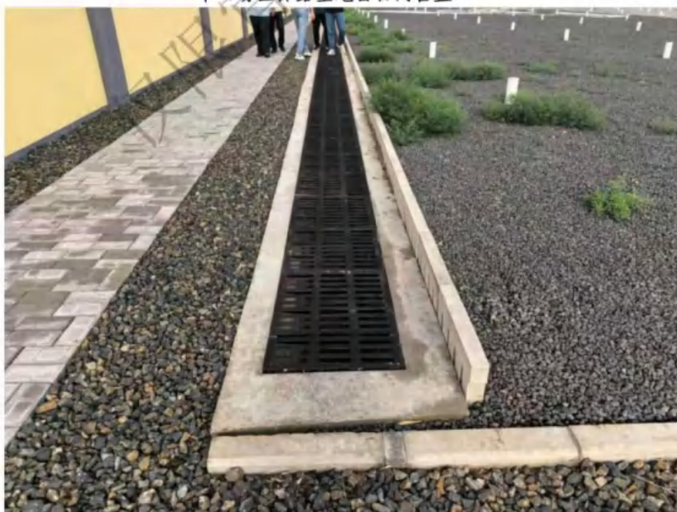
混凝土排水沟
