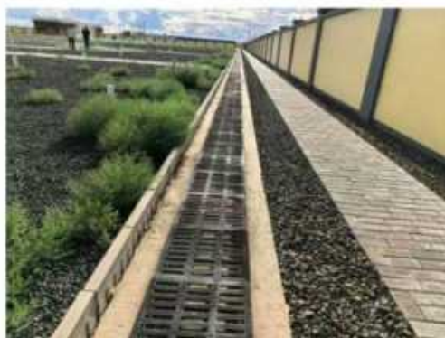
中心场区混凝土排水沟
