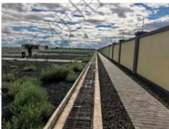
中心场区碎石铺垫、普通透水砖
