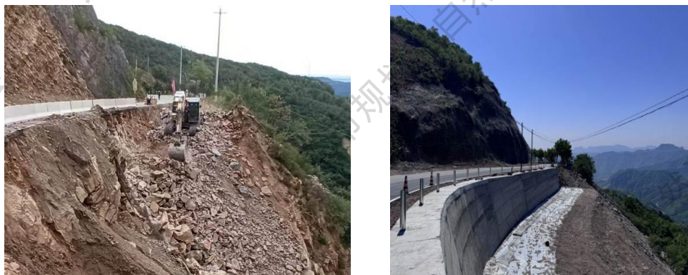
图 4.2.7-6 陡坡路基水毁重建实施情况
