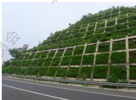
图 4.3.6-1 锚杆（索）框架植被防护
