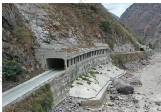
图 3.5.3-2 棚洞式隧道型式
