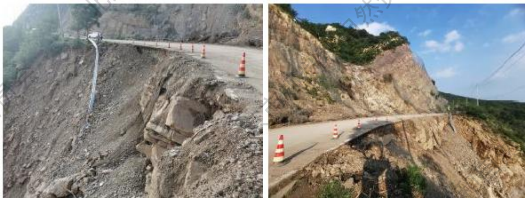
图 4.1.2-2 路基边坡失稳损毁
