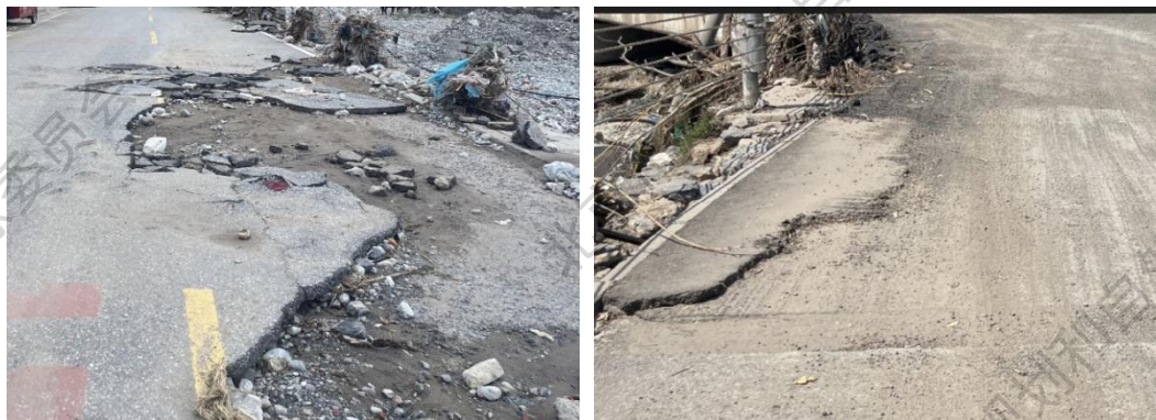
图 4.1.2-6 沥青混凝土面层剥落
