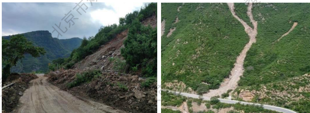
图 4.1.2-5 滑坡、泥石流类地质灾害造成公路损毁
