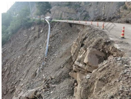
图 4.2.7-4 沿河公路受洪水冲刷造成路基边坡垮塌
